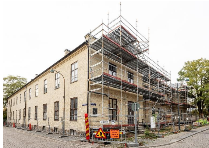
Murpoolen, Malmö Mur & Puts, Cortex och Helsingborgs Fasad & Kakel samarbetar i en omfattande renovering av kvarteret Maria Magle i Lund
