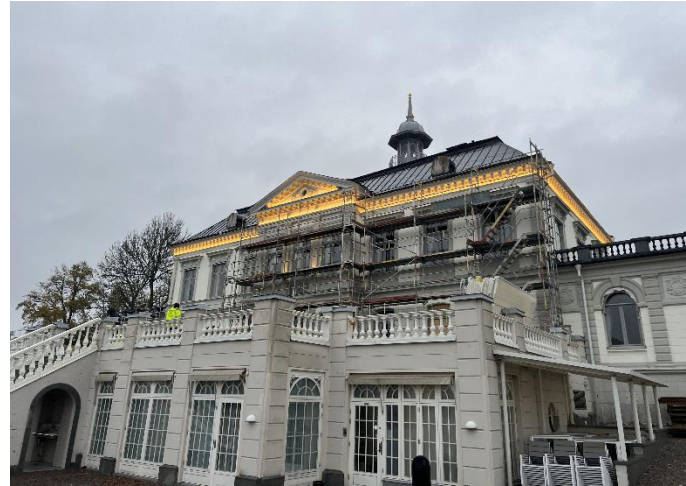
På Bro Hof Slott samarbetar STARK Fasadenoveringar och Bruske-Delér Fönsterrenoveringar med en exteriörrenovering
